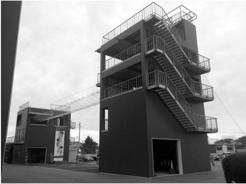
▲相馬地区広域消防本部横、訓練用施設
