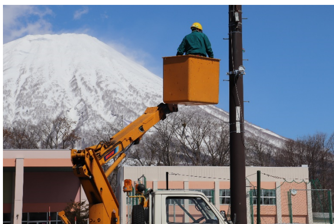
防犯カメラ設置中
